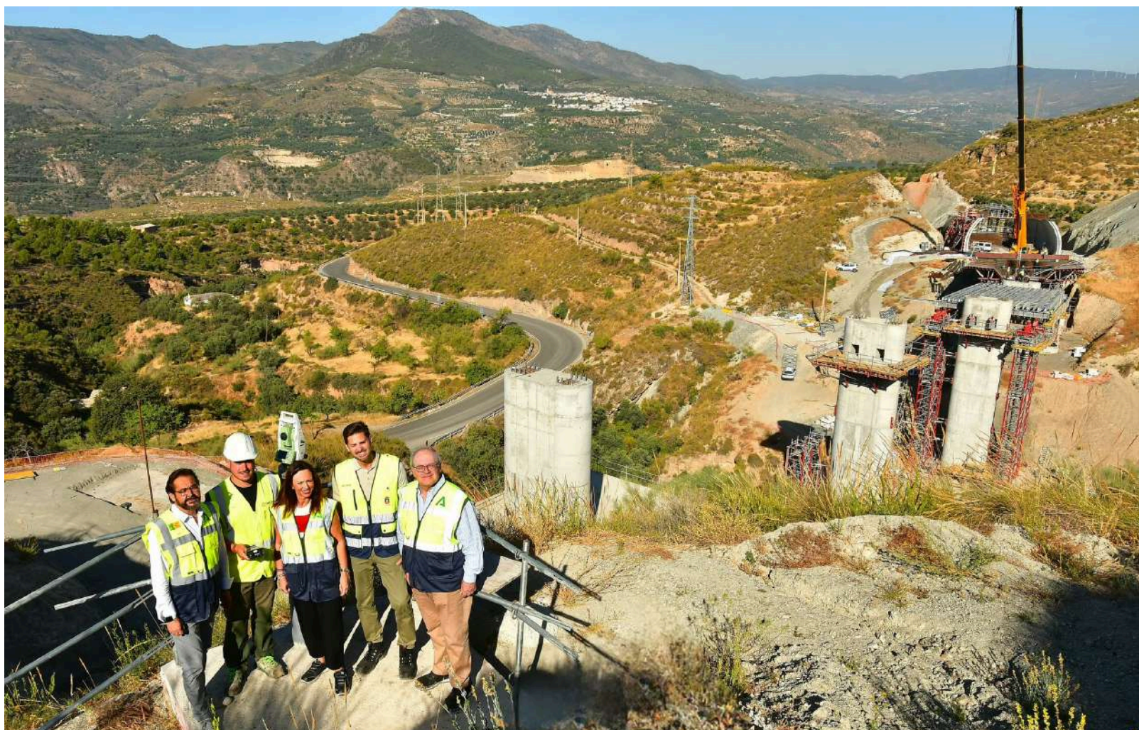
La consejera de Fomento en funciones, Rocío Díaz, visita las obras de acceso a la Alpujarra. Foto Junta de Andalucía.
