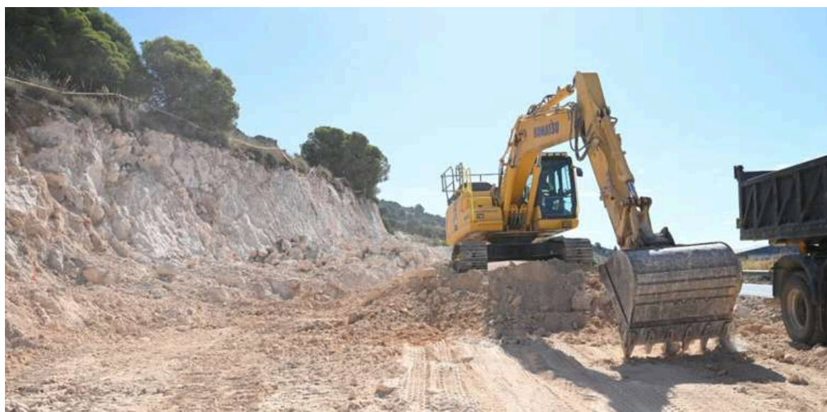
Comienzan las obras de la segunda fase de acceso a la Alpujarra por Lanjarón
