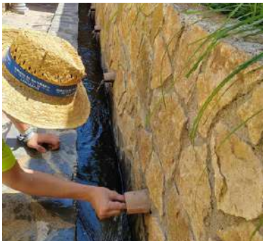
Labores de mantenimiento
