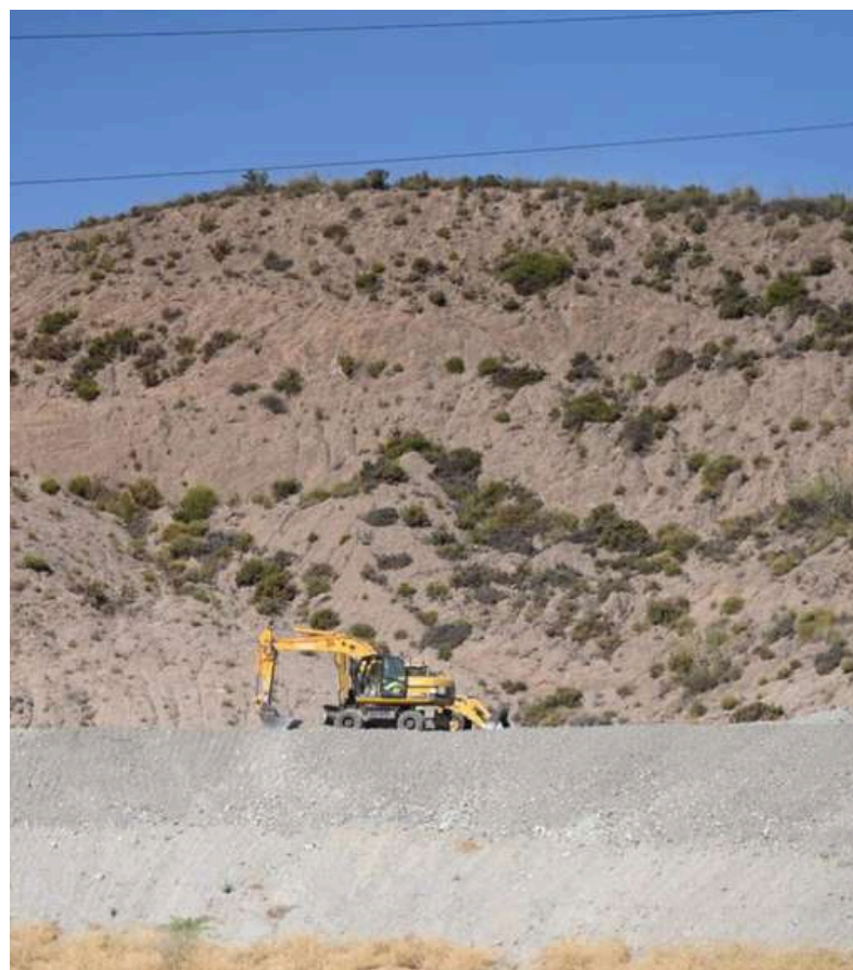
Imagen del avance de la primera fase de las obras
