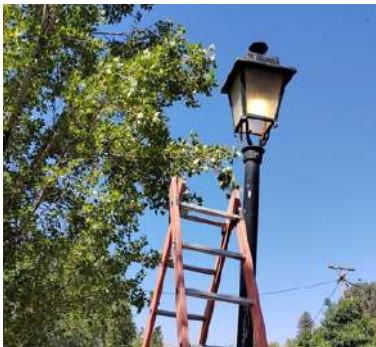
Labores de mantenimiento
