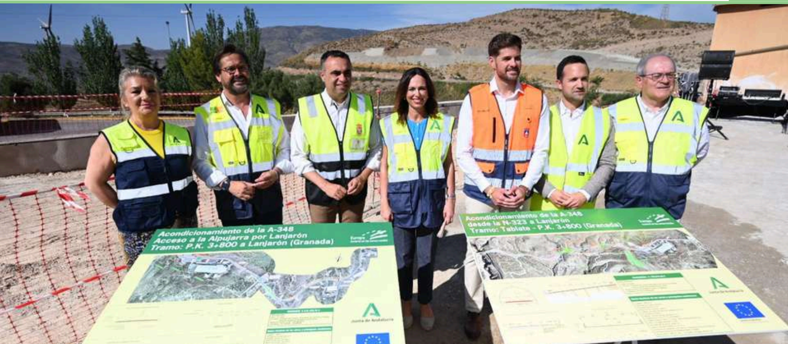
Imagen del inicio de las obras del segundo tramo del acceso a la Alpujarra de Granada
