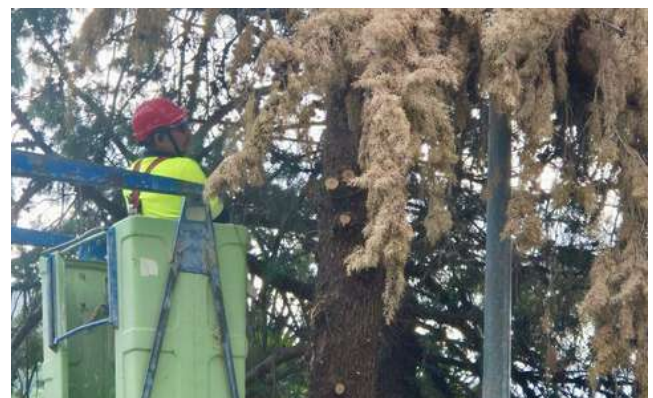
Labores para la retirada de árboles en mal estado
