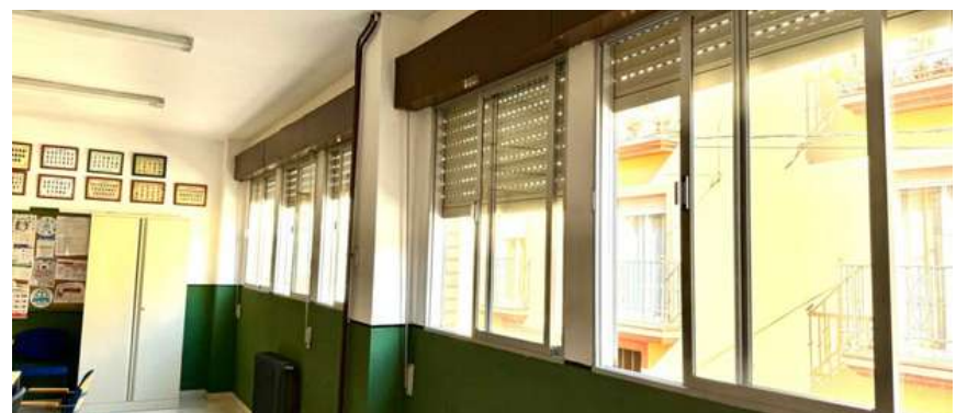
Ventanas del centro que se sustituirán
