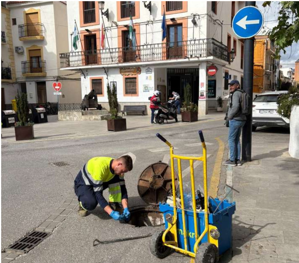
Empleado realizando las labores de desinfección en alcantarillado
