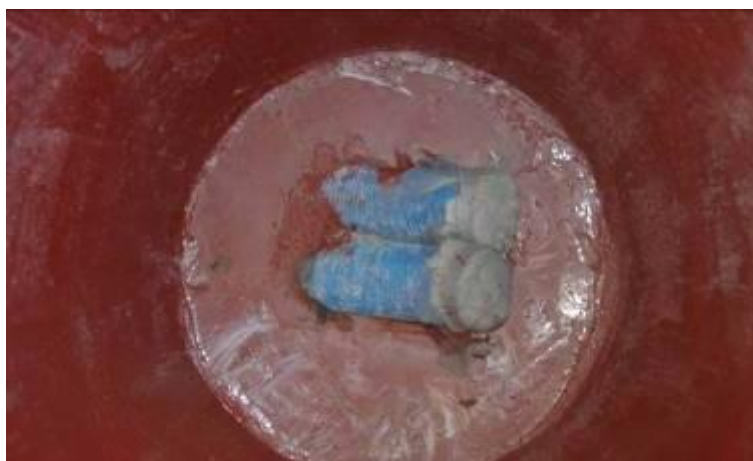
Fotografía 5. Emboquille de tubería drenante en zanja colectora.
