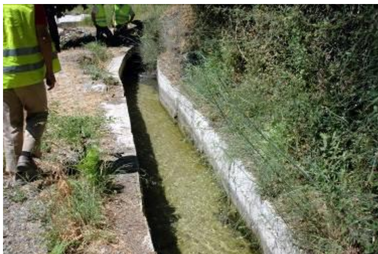
Fotografía 3. Canalización e impermeabilización de las acequias (acequia Secarta).
