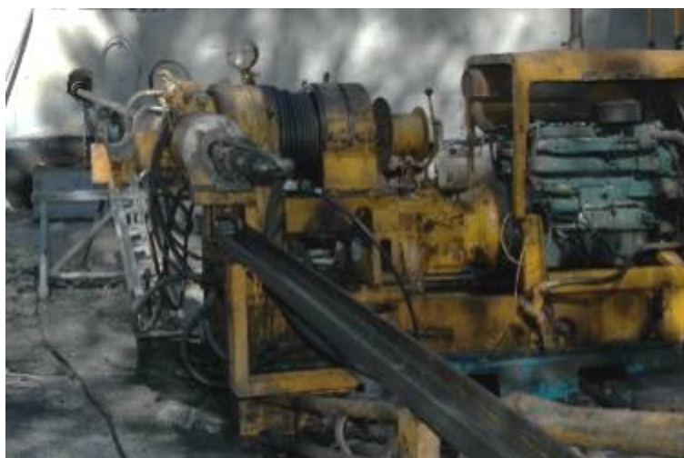
Fotografía 2. Máquina Longyear en perforación de sondeos horizontales en la Huerta de Las Monjas (Lanjarón).
